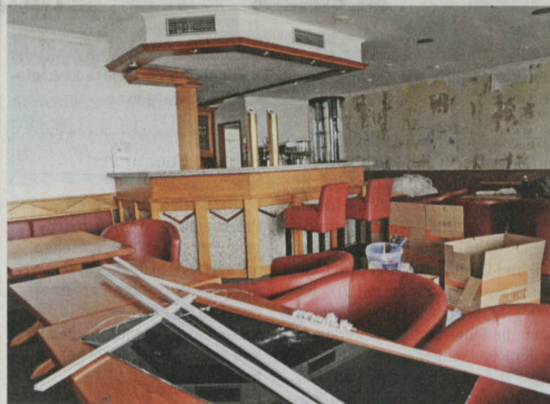
Zurzeit laufen die Renovierungsarbeiten im Café am Kirchplatz in Tönisheide auf Hochtouren.
