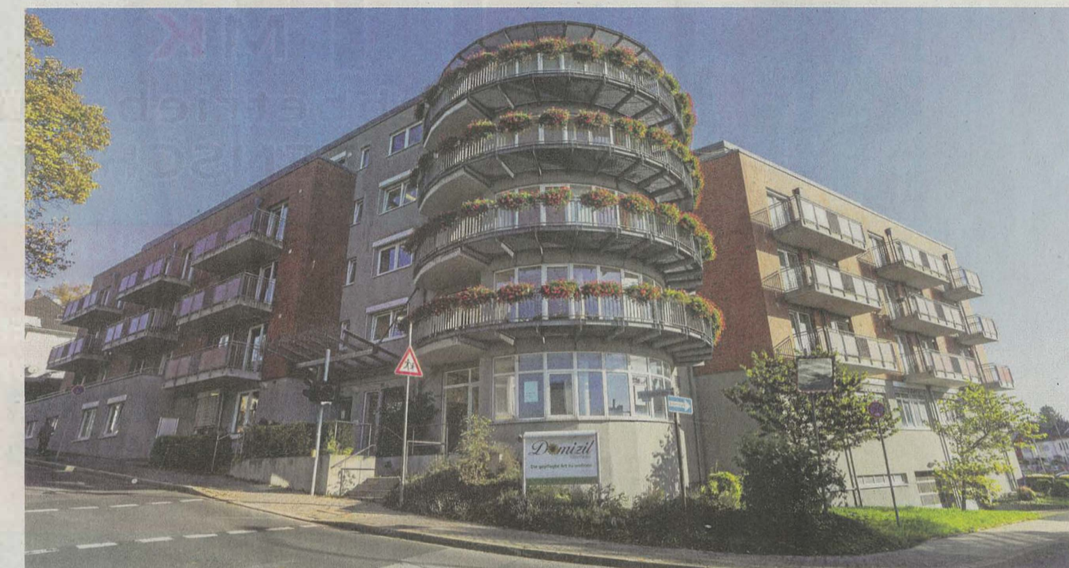
Schon über ein Jahr still steht die ehemalige Seniorenresidenz Domizil an der Wülfrather Straße in Heiligenhaus.
